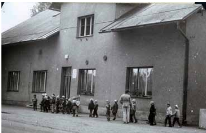
Mateřská škola po celkové rekonstrukci v minulých letech
