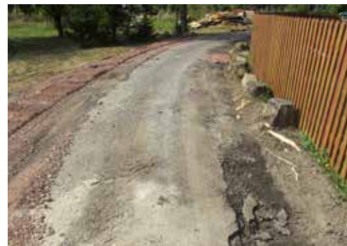
Průběh rekonstrukce komunikace na Houkov.
