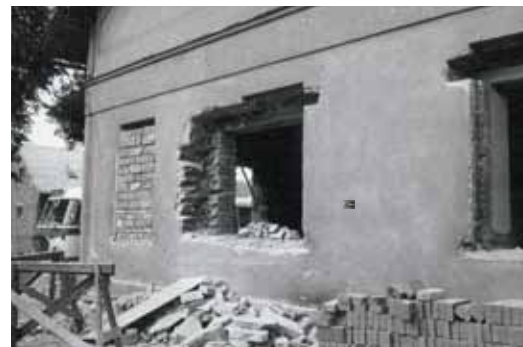
Přestavba MŠ – výměna oken
