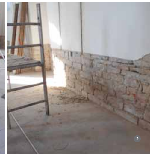
Kaple sv. Antonína prochází další etapou plánované rekonstrukce, v současné době je vše vystěhováno. Otlouká se původní vnitřní omítka zhruba do výšky 1 m, vnitřní viditelně vedená elektroinstalace bude nahrazena zapuštěnými rozvody v omítce. V nejbližších dnech budou vyměněna původní okna za nové dřevěné. Poté budou provedeny uvnitř kaple sanační omítky.
