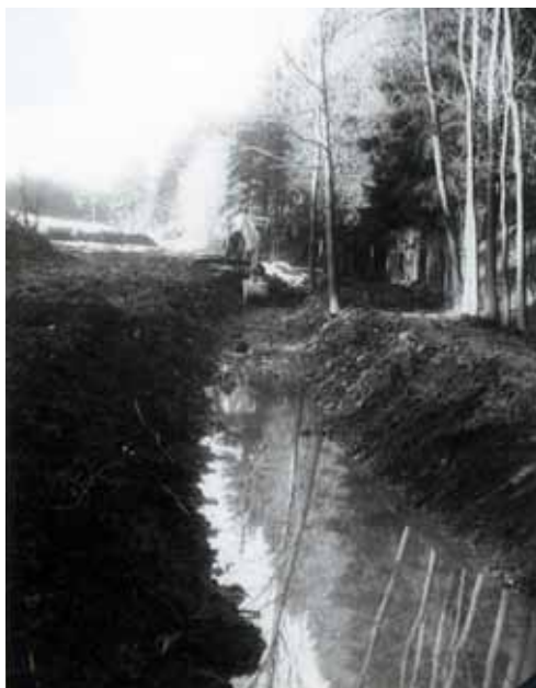
Prohloubené koryto Kamenského potoka v Dolích
